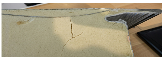
Fig. 2: Exemple de rupture du polyuréthane
